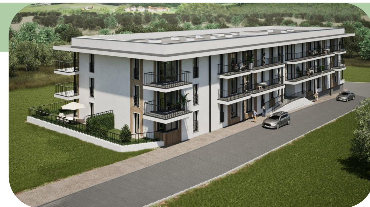
Widok od strony północno-wschodniej
