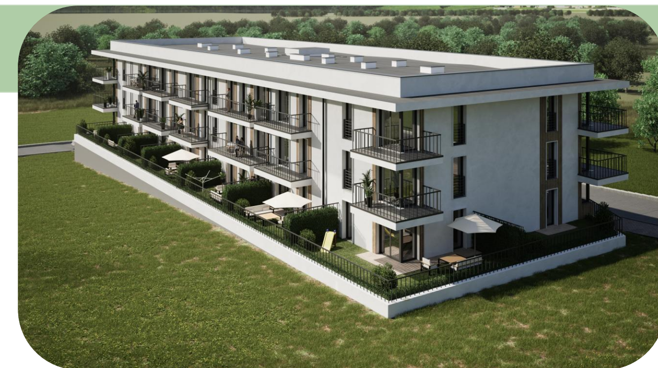
Widok od strony północno-wschodniej
