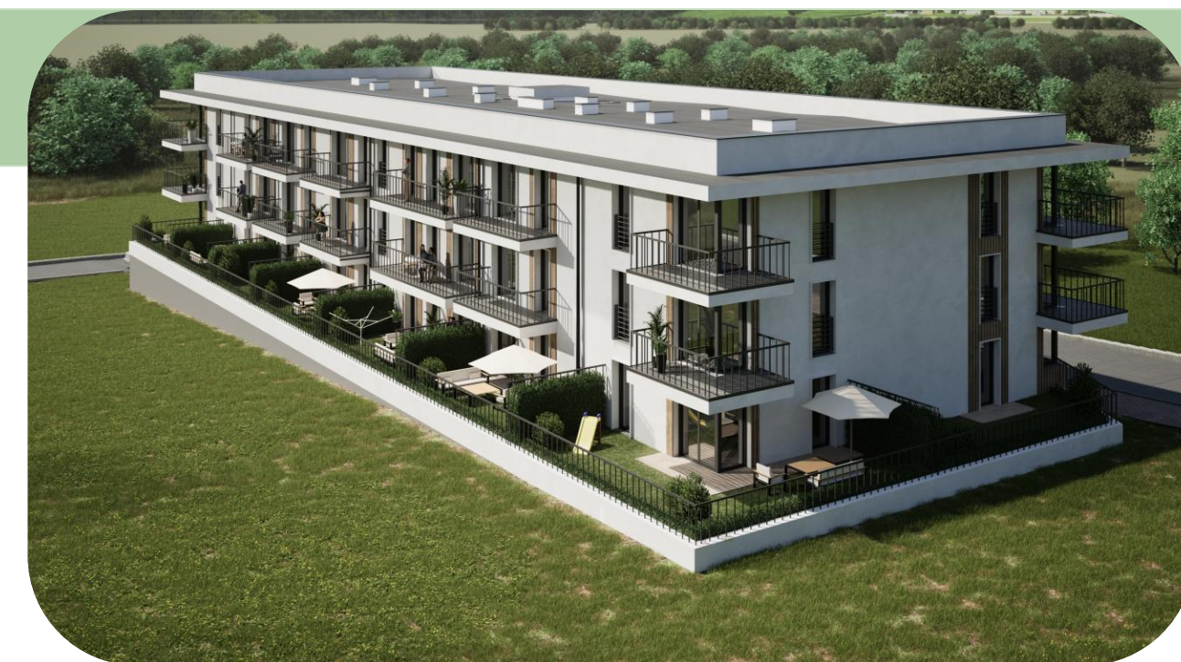
Widok od strony północno-wschodniej
